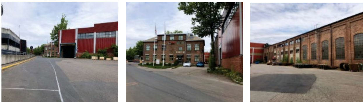
Figur 2 - Fotografier fra planområdet med nyere tilbygg til venstre, administrasjonsbygget i midten og verkstedbygningen til venstre.
