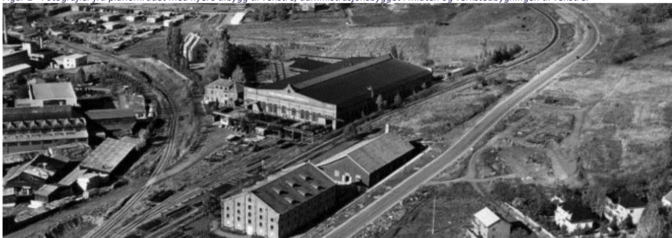
Figur 3 - Historisk bilde av verksteds- og administrasjonsbygg
